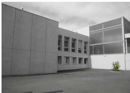
2) Vue de l'extérieur
